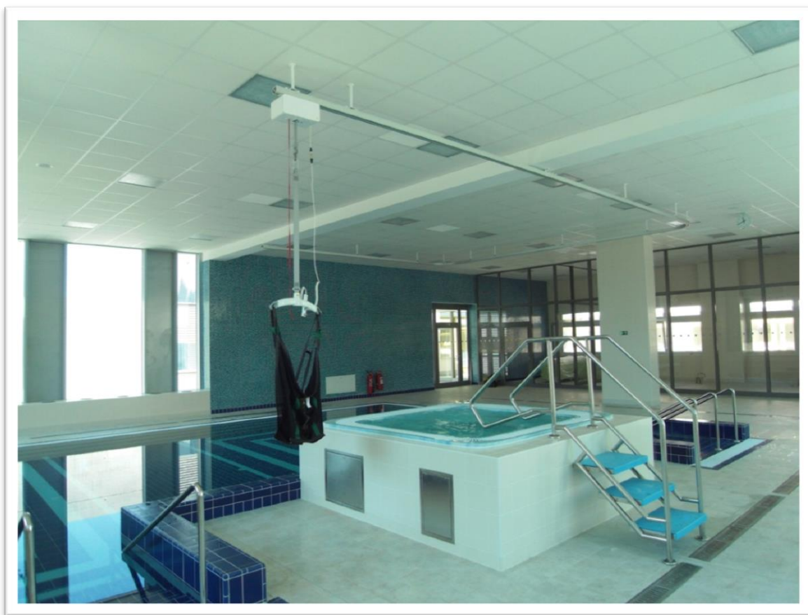
Příklad instalace, stropní zvedací systém GH3 , Nemocnice Třebíč, Altech s.r.o.
